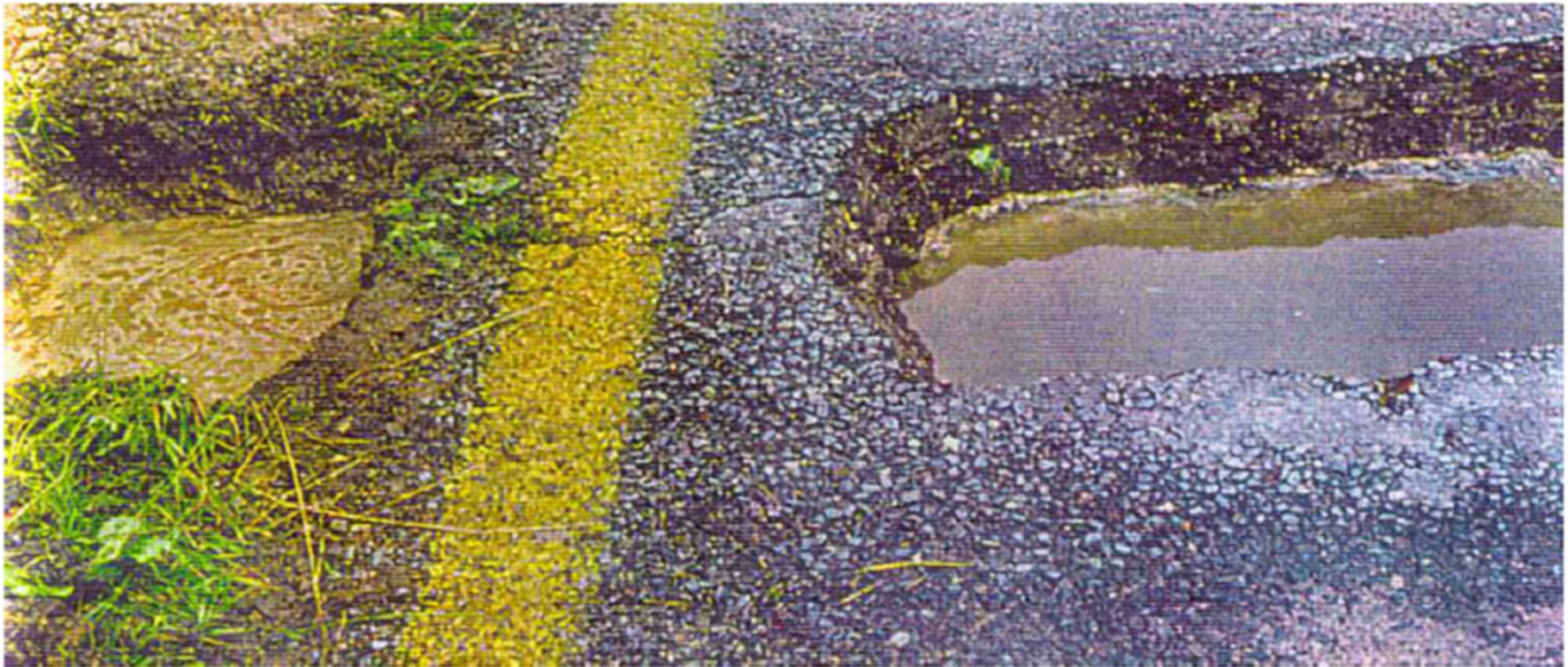
Photo 54 : Présence d'eau dans le corps de chaussée
